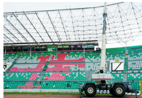
AVANCE. Retiran techo del sector de preferencia. Las cabinas de prensa pasarán al sector general.
