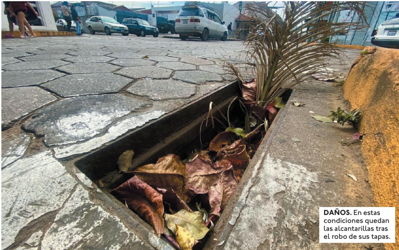
**DAÑOS.** En estas condiciones quedan las alcantarillas tras el robo de sus tapas.
